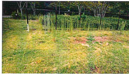
【施工前】（前回散布圧力：約80kg/m 2 ）
