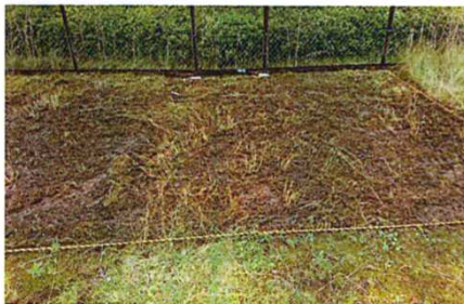
【施工後】（散布圧力：約 200 k g/m 2 ）
